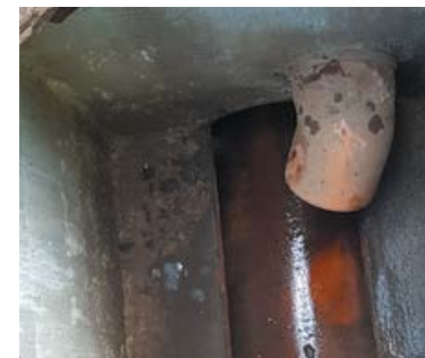
Inspection et entretien de notre réseau d'égouts
