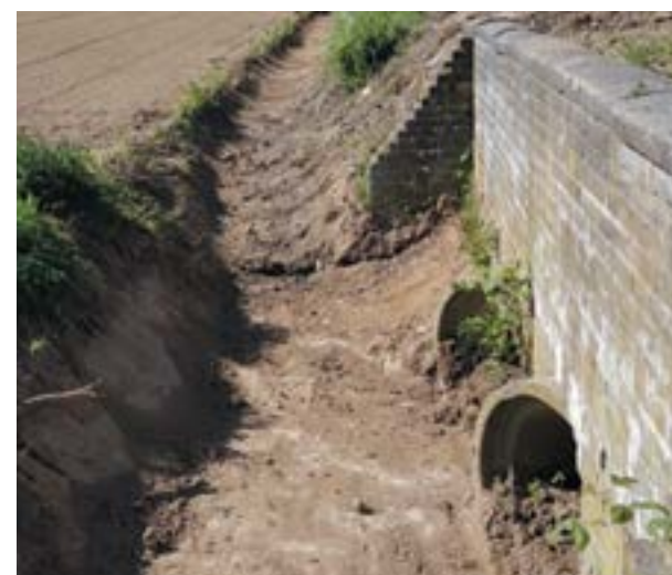
Collaboration avec le SPW pour entretien des tuyaux sous la RN 63
